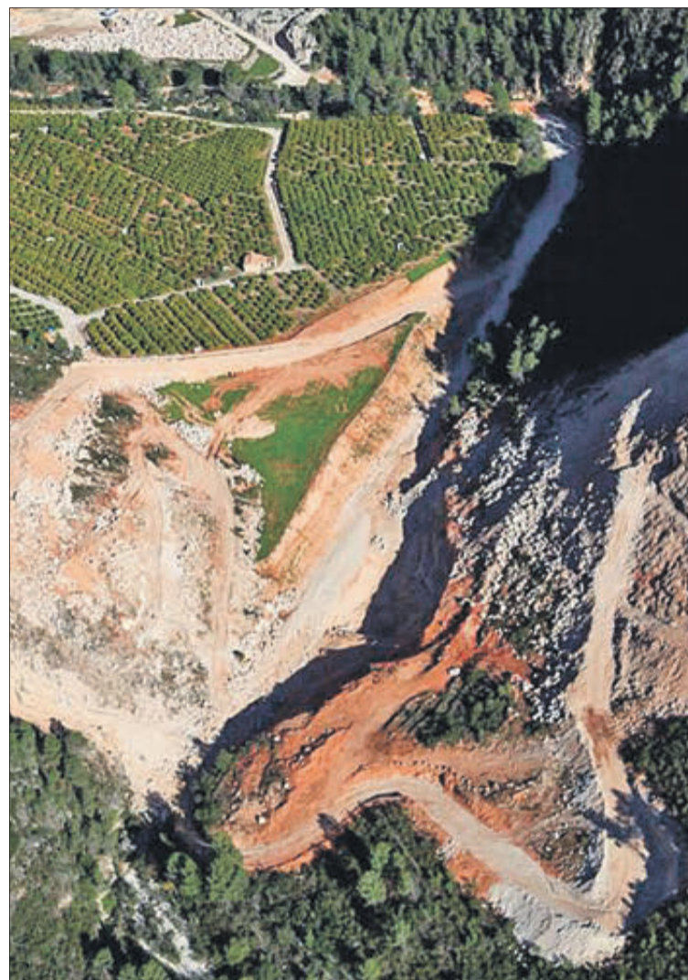
Una imatge dels treballs inicials per a la construcció de la presa.
