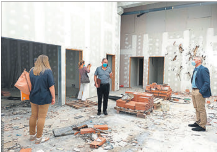
L'alcalde, David González, i els tècnics, en una visita a l'edifici.
